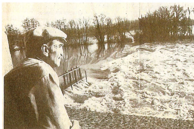
Le barrage du moulin de la minoterie Barrau, à Porchères. Ce minotier constate que la différence de niveau n'existe plus et que les eaux bouillonnent. Les turbines ne fonctionnent plus.
