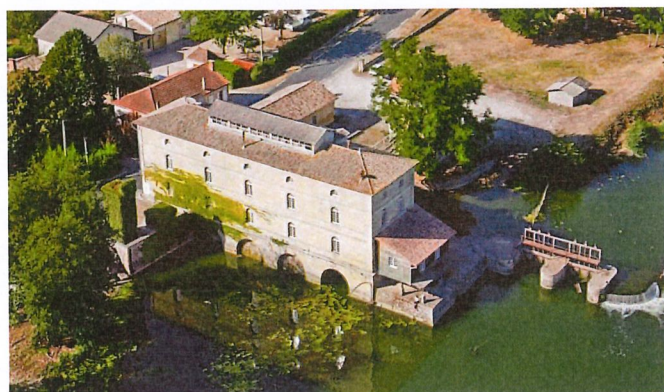
Vue aérienne du moulin
