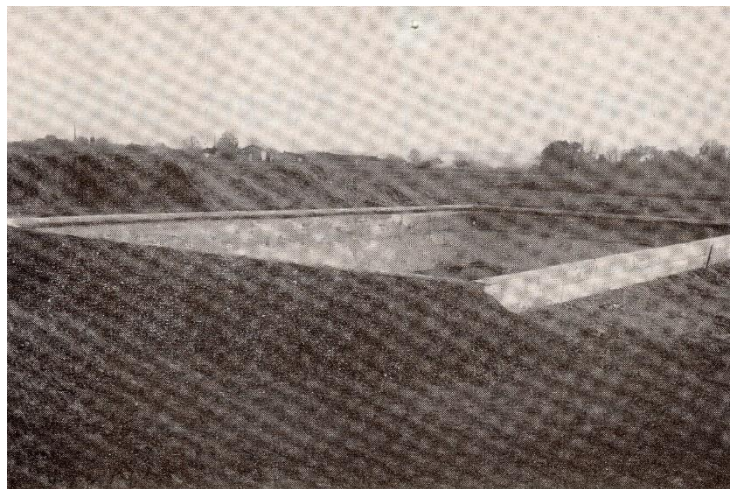
La piscine a pris forme. Les travaux ont bien avancé : 7.000 heures bénévoles pendant 2 mois de grandes vacances.
